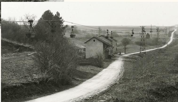
*Ci-contre à droite : transbordeur aérien à wagonnets transportant le calcaire concassé de la carrière à l'estacade de chargement des péniches en 1932 [125]*
